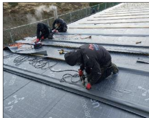
Zur Erstellung eines wasserdichten Unterdaches wurde die Konterlattung mittels materialhomogener HIGH-TECH UDB First- und Gratstreifen in die Abdichtung eingebunden. | Foto: Dachdeckerei Schulz
