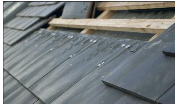
Die Biberschwanzklammer 425-031 von FOS sichert den Edilians Stretto auf der Dachfläche des Bauabschnitts Knightbridge zuverlässig gegen Windsoog.
