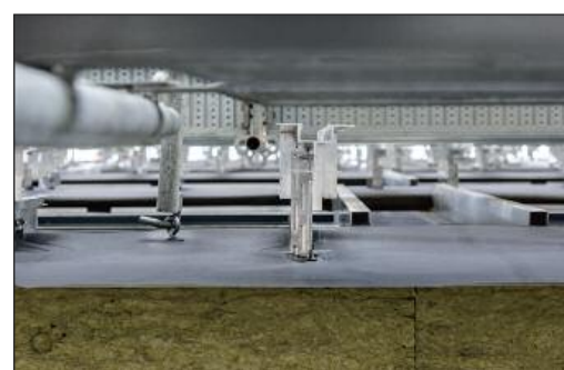
Die Fassadenunterkonstruktion besteht aus Aluminiumprofilen und der schwer entflammaren Fassadenbahn DELTA-FASSADE 20. Die Durchdringung der Fassadenbahn wurde systemgerecht ausgeführt. Dabei war die Anforderung, dass das Klebeband auf unterschiedlichen Untergründen haftet.
