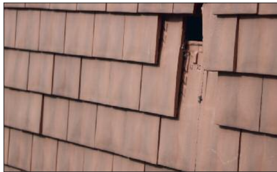
Die Biberschwanzklammer 425-031 von FOS fixiert den Edilians Stretto an der Fassade normkonform nach NEN 6708 und ermöglicht den werkzeuglosen Austausch einzelner Ziegel.
